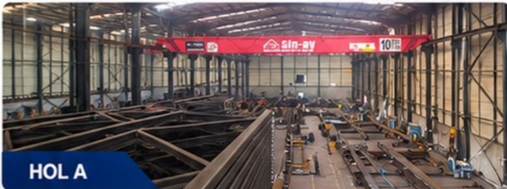
Fabrika İç Holü – Genel Görünüm
